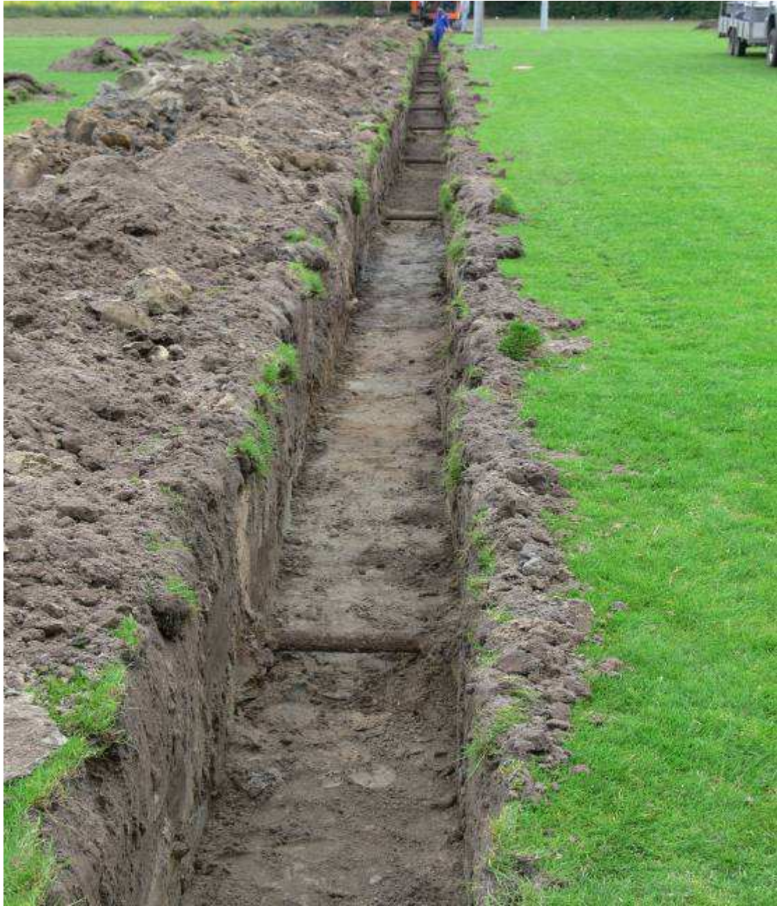
Aanleg van de het nieuwe drainagesysteem
